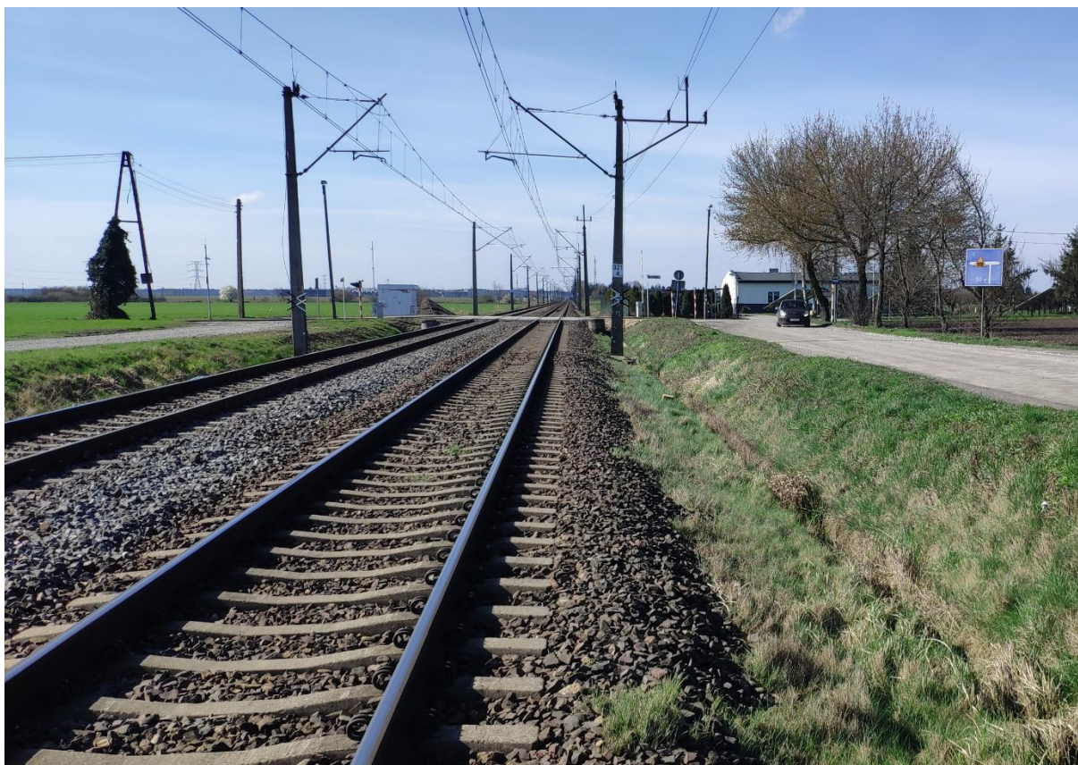
Rysunek 1 Widok z toru nr 1, widoczne rowy boczne i drogi równoległe do toru
